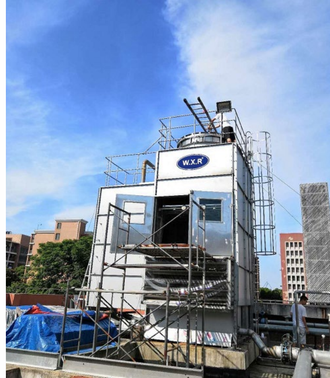
华电电科院及上海市重点实验室填料试验台
